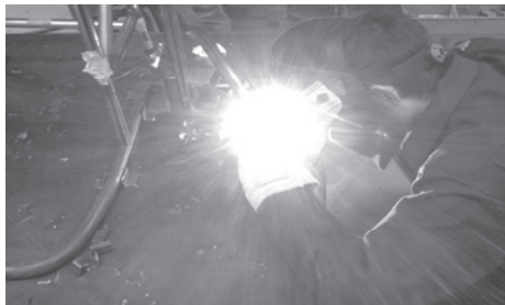
図1 フレーム製作の様子(溶接作業)
