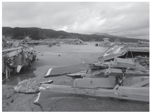
写真3 東日本大震災 広田湾の防潮堤決壊 2011.4.2
