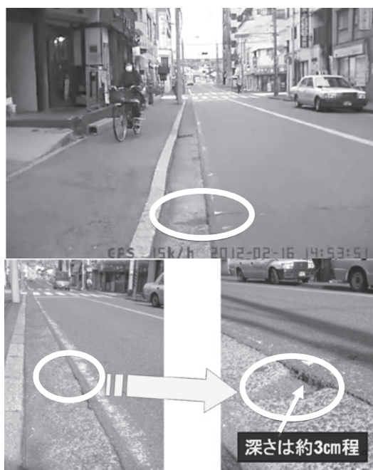
図2 リンレコで出来る道路性能評価。片側1車線通学路車道左端走行時、見えない路面窪み(3cm)で衝撃!(2012)。
